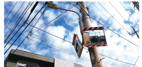
安全な通学路のため、電灯を設置しました!
