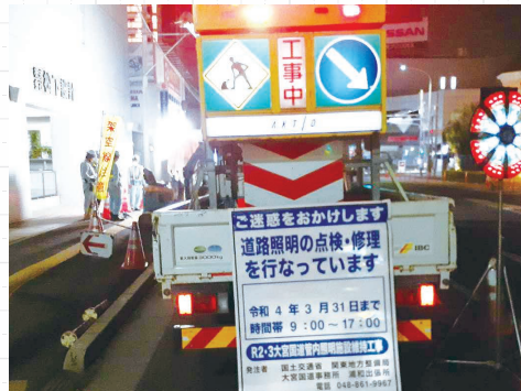
国道街灯新設
