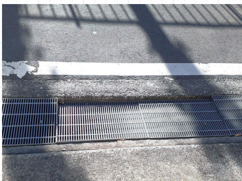
上落合公民館 工事後の側溝修繕
