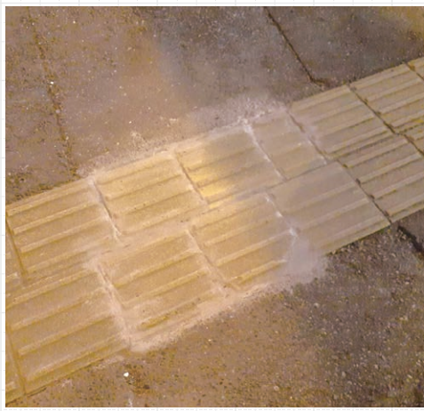
点字ブロックの補修
