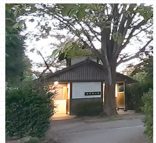
上落合公園 多目的トイレ照明修繕
