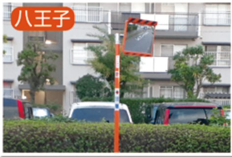
カーブミラー新設
