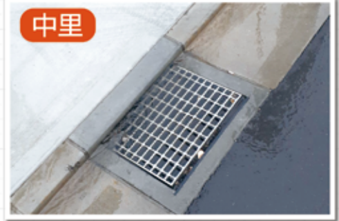
排水マスの堆積土砂の撤去
